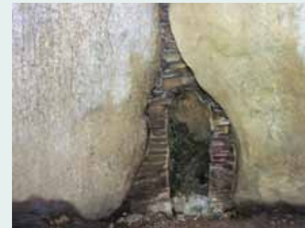
Delesten mellem to af kammerets store bæresten omgivet af tørmur med opstabilede stenfliser.
