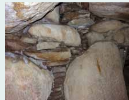
Højdeforskellen mellem bærestenene er udjævnet med indskudte sten som giver en plan flade for de overliggende dæksten.
